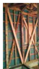
木造住宅の耐震改修工事
