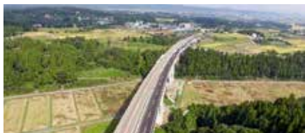
4車線化完成区間（五箇山IC～城端SIC）
