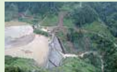
洪水時の城端ダム
