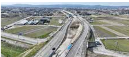
整備を進めている高岡環状道路（高岡市上伏間江～佐野）
