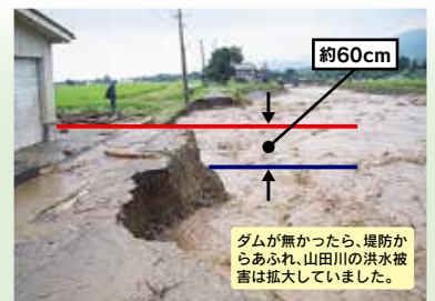
— : ダムが無かった場合の推定水位 — : 洪水時の水位(堤防天端より20cm下方)
