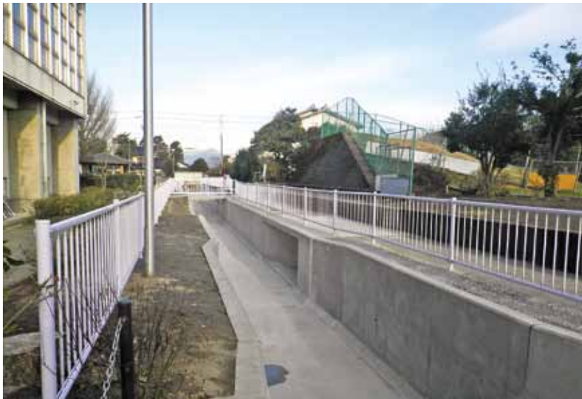
水新建設（株）施工の「用排水施設整備下大久保地区下大久保用水路第6工区工事」
