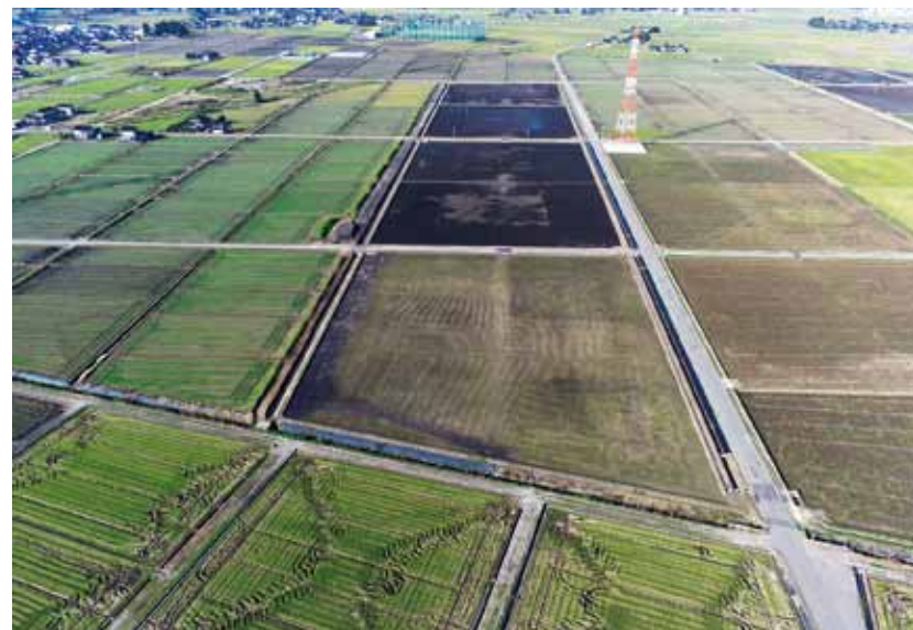
高田建設（株）施工の「ほ場整備水戸田地区ほ場整備第1 2工区工事」
