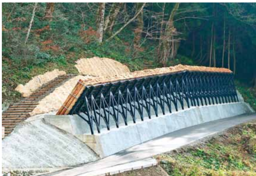
(株) 長田組施工の「環境防災林整備田向山腹工事」
