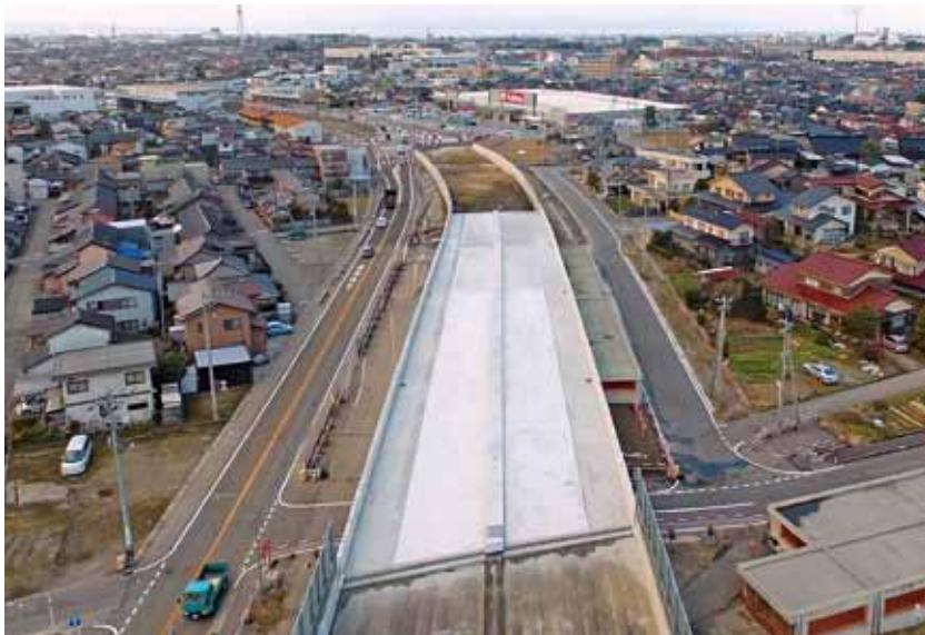
川田建設(株)北陸支店施工の「一般国道415号道路総合交付金富山東バイパス東富山跨線橋上部工工事」
