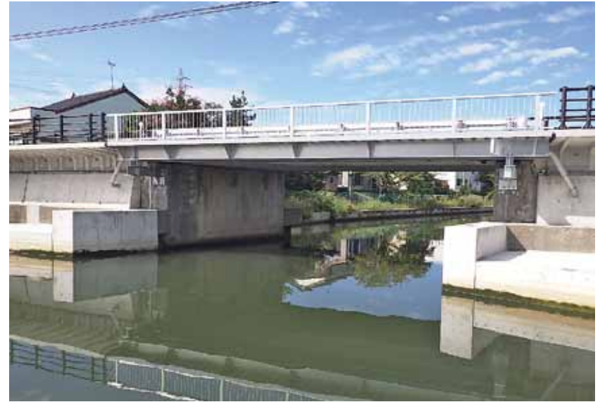
藤川建設(株)施工の「一般県道蓮町新庄線県単独橋りょう維持修繕 蓮町橋歩道設置工事」
