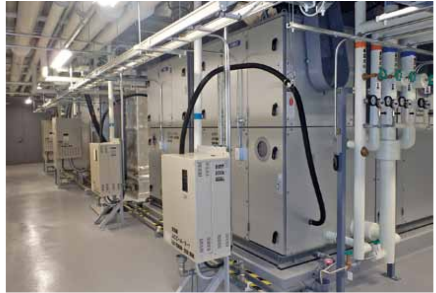
北陸電気工事・アルタ・ユウホー設備新富山県立近代美術館 （仮称）新築空調設備工事共同企業体施工の「新富山県立近代 美術館（仮称）新築空調設備工事」
