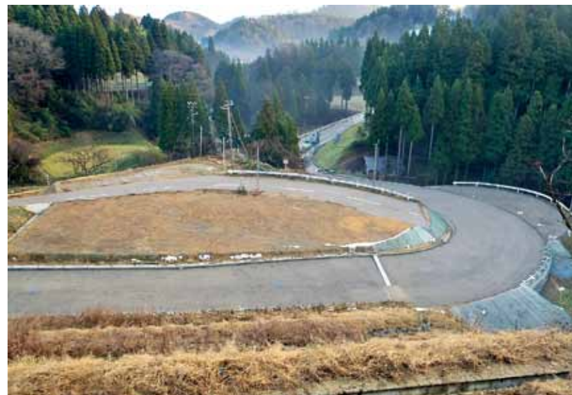
山田建設(株)施工の「一般県道井栗谷大門線県単独道路改良工事」
