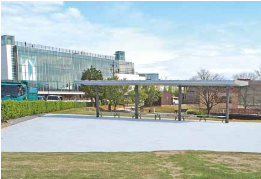
日本海建興(株)施工の「富岩運河環水公園公園総合交付金 promenade整備第1工区工事」
