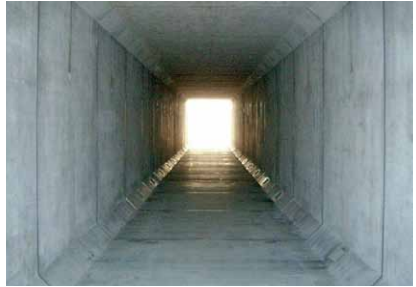
(株)関口組施工の「鴨川河川総合交付金放水路第3工区工事」
