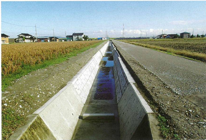
射水工業(株)施工の「ほ場整備広上地区4号排水路第2工区工事」
