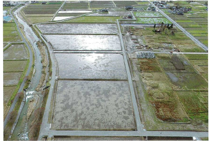
竹田建設(株)施工の「ほ場整備窪田地区第9工区ほ場整備工事」
