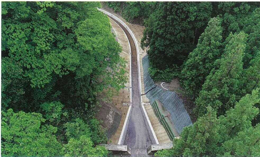
中越ロジスティクス(株)施工の「予防治山頭川流路工事」
