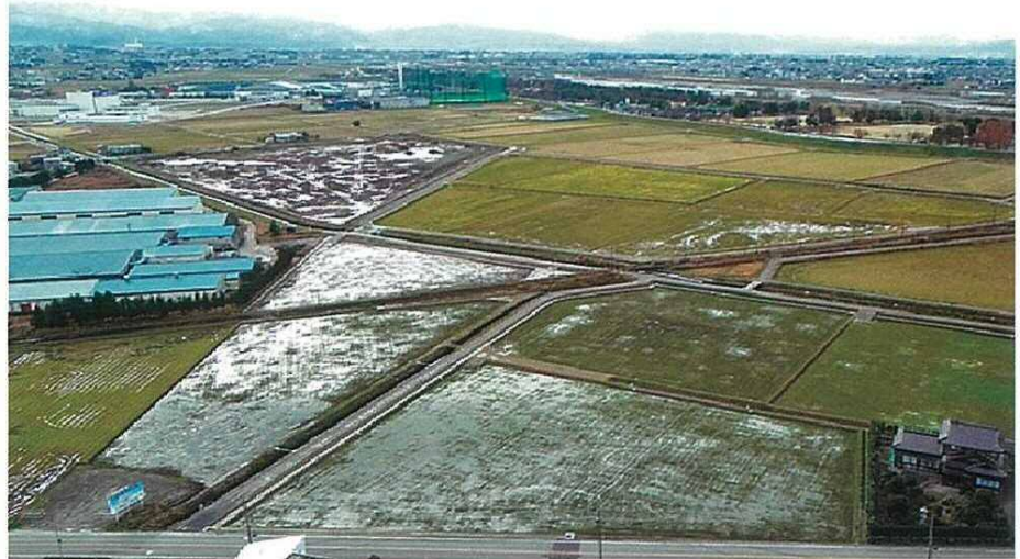
丸新志鷹建設(株)施工の「ほ場整備水橋常願寺地区第5工区ほ場整備工事」
