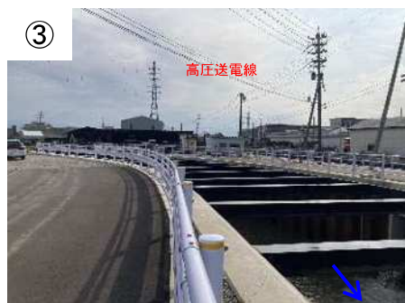
施工済み区間
