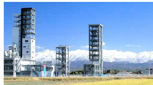
①主訓練塔 高さ45m(全国トップクラス)
