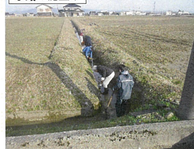
水路の泥上げ
