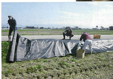
草刈り作業が危険な箇所に 防草シートを施工
