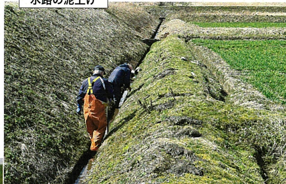
水路の泥上げ
