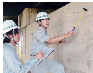
▲橋の状況について確認する様子
