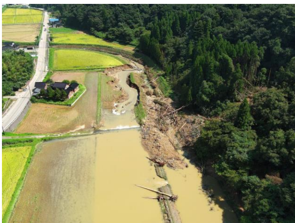
山地崩壊による河川閉塞と農地への土砂流入 (氷見市余川地内)
