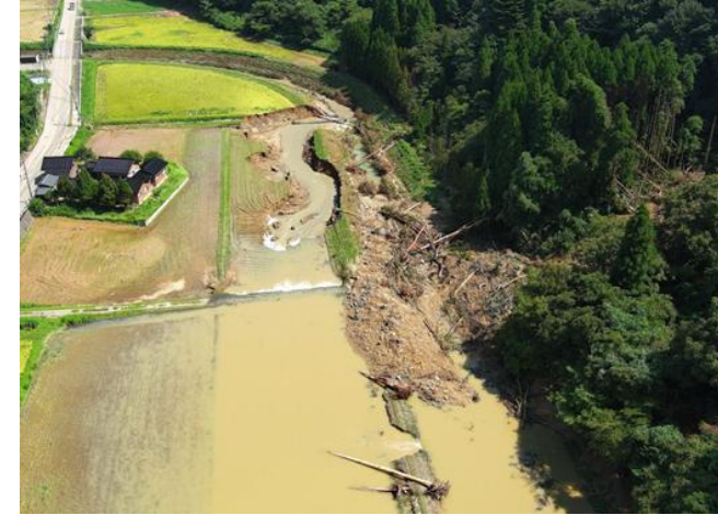
余川川決壊による農地への土砂流入及び冠水 (氷見市余川)
