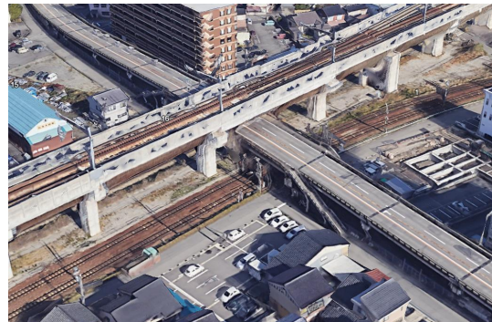
街中の高架橋
