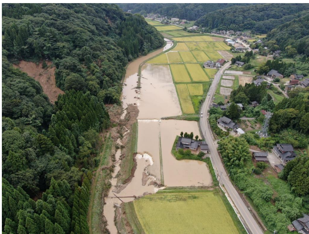
山側斜面崩落による余川川の河道閉塞状況（氷見市余川地区）
