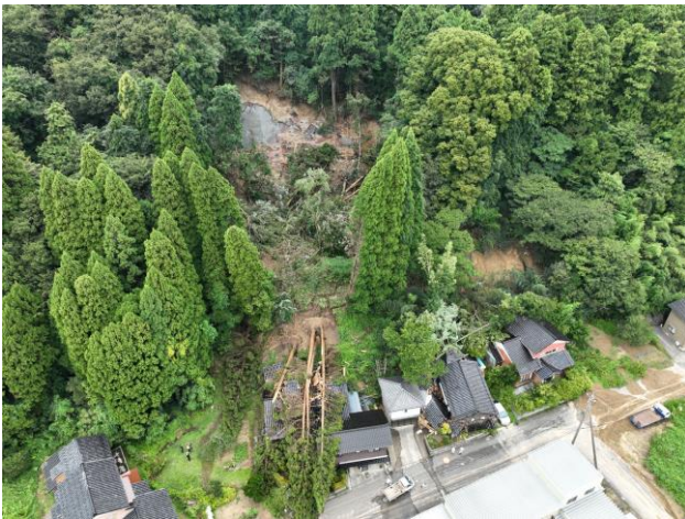
住家裏の斜面崩壊による被災状況 (氷見市阿尾地区)
