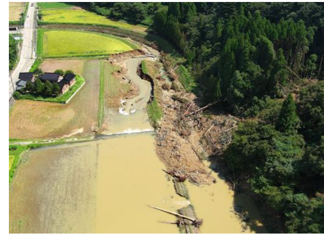
余川川決壊による農地への土砂流入及び冠水 (氷見市余川)
