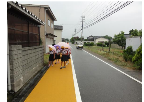
道路の交通安全対策（路肩拡幅後）
