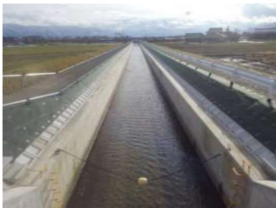
排水路の整備（南砺市）
