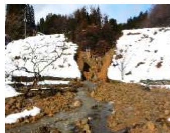
破堤したため池（氷見市）
