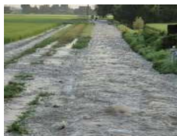
溢水した農業用水路（高岡市）
