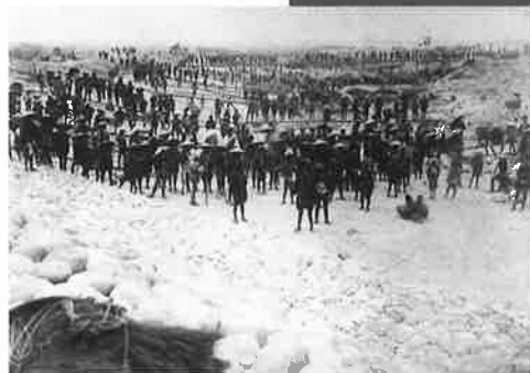
明治24年 常願寺川改修工事
