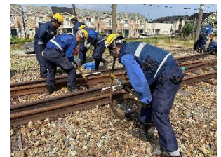
空調服着用の作業風景
