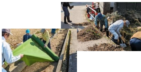
地域ぐるみの共同活動（水路の泥上げ、防草シート施工）
