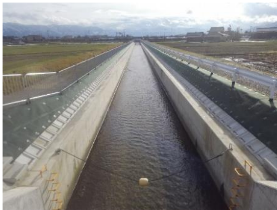
排水路の整備(南砺市)
