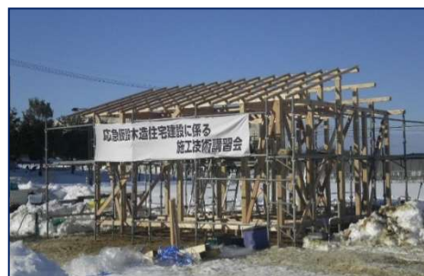
応急仮設木造住宅建設に係る施工技術講習会
