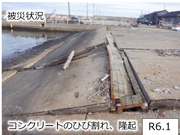
堀岡船だまり 船揚場（射水市海竜町）
