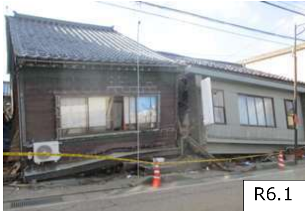
倒壊家屋の公費解体 (氷見市北大町)
