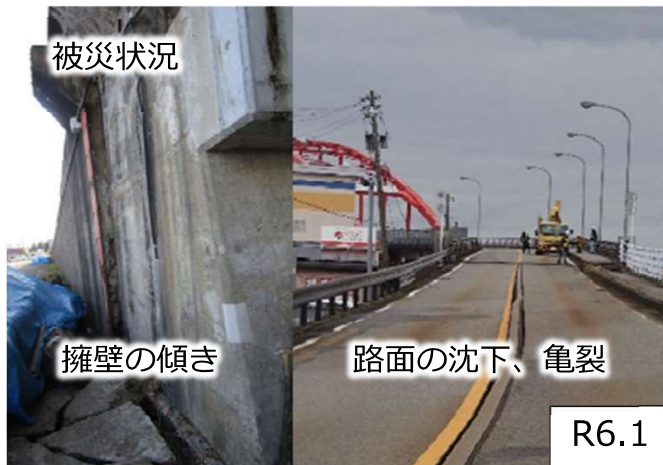
臨港道路1号線 伏木港大橋（高岡市伏木1丁目）
