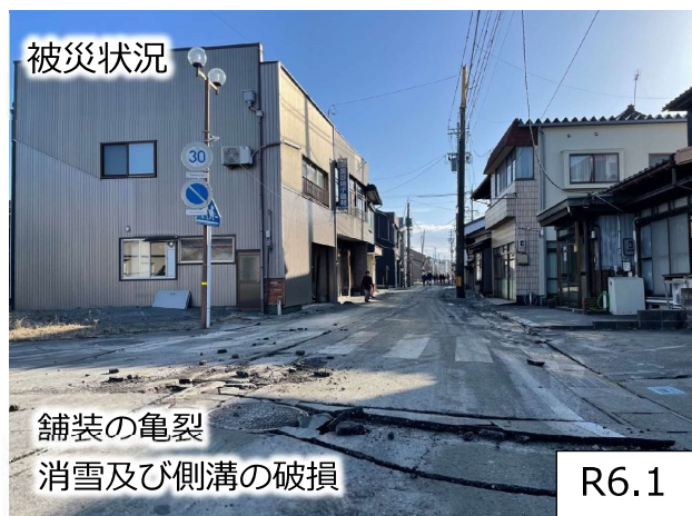
県道中道国分線（高岡市伏木中央町）
