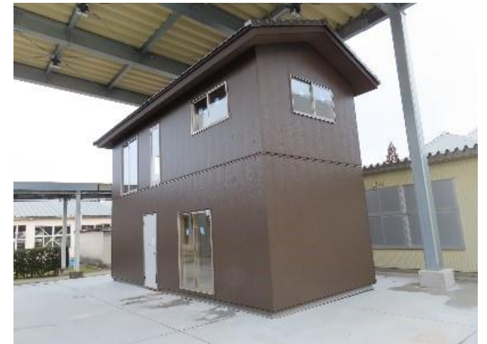
訓練用設備等の整備 （建築総合実習装置）
