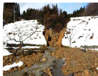
破堤したため池（氷見市）
