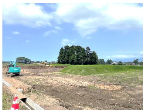
地元建設業者との連携によるほ場条件の改善
