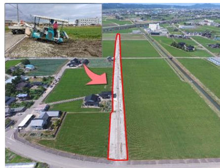
農地の大区画化とターン農道の設置(高岡市)
