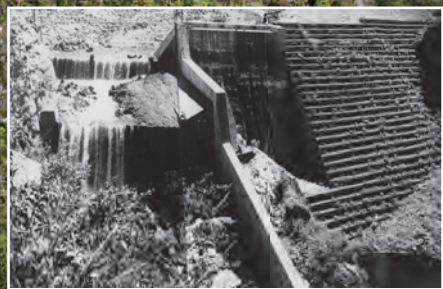
建設当時(昭和14年)
