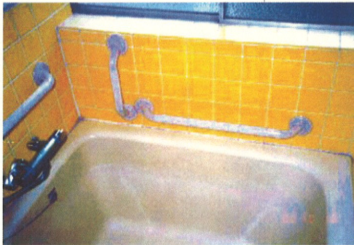
▶ 浴槽部分に垂直・ 水平手摺を設置 ▶
