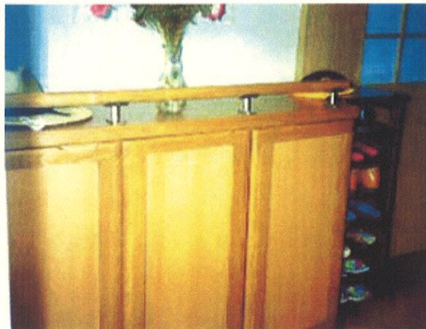
▲下足箱の上に手摺を設置
