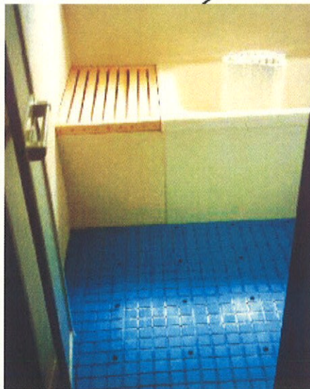
▲腰掛け部分を設置
