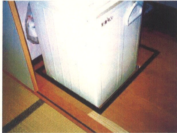
▲洗濯機を床に埋め込み使いやすい高さにする
