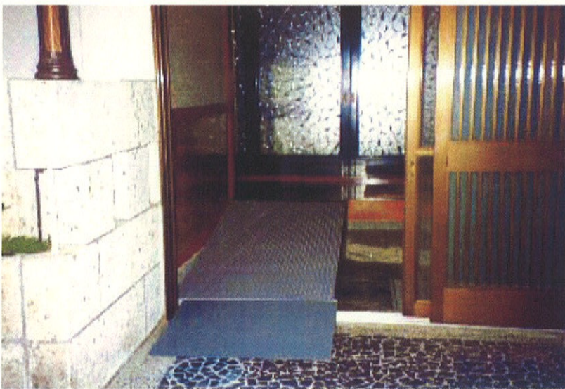
▲玄関戸をはさんだスロープ
