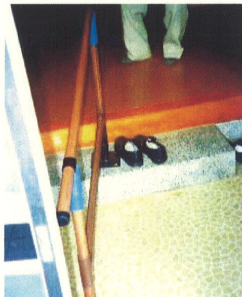
▲玄関の中央に床付手摺を設置
