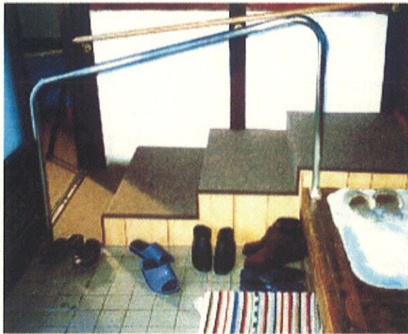
▲玄関の段差に階段と手摺を設置する
