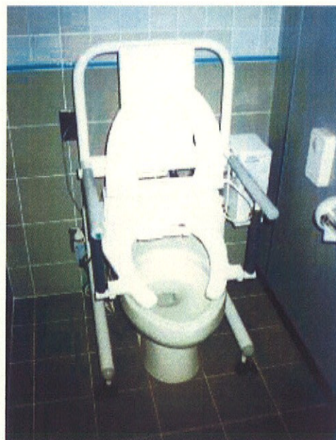
▲電動簡易昇降便座設置
