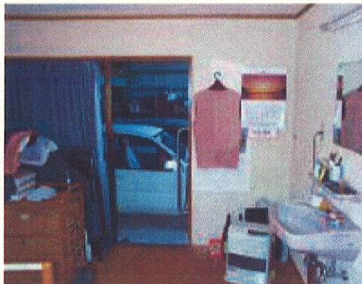
▲車庫に直接出入口を新設
