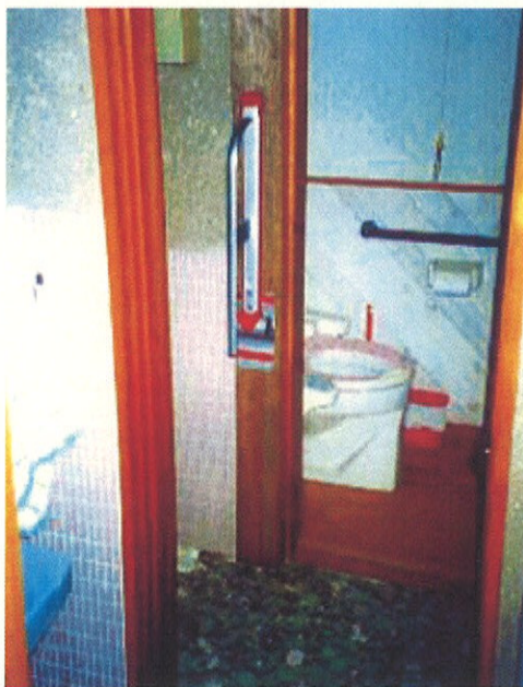
▲小便器前に上下式手摺を設置
