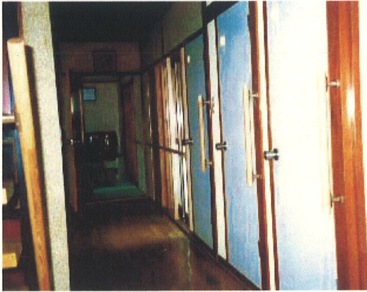
▲出入口部分等、連続に手摺を巡らすことが困難なため出入口の両側にたて手摺を設置した例
