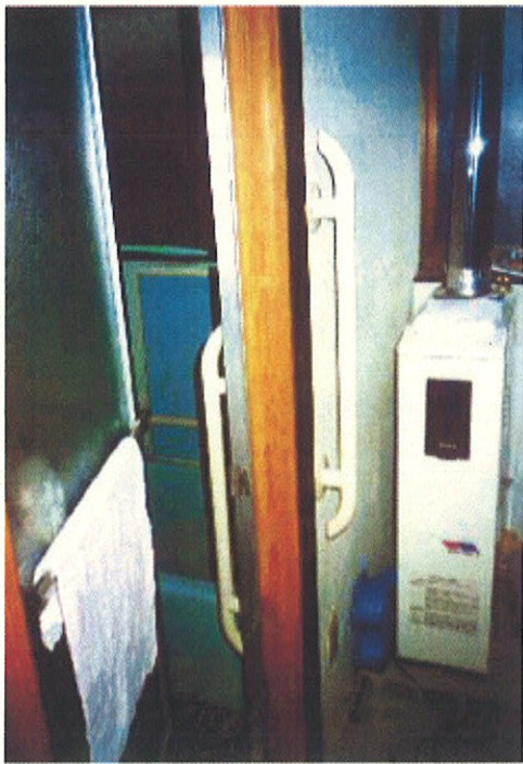
◀ 浴室の出入り口扉の前後に 垂直手摺設置
