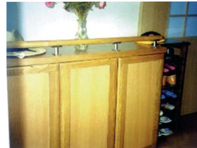
▲下足箱の上に手すりを設置
