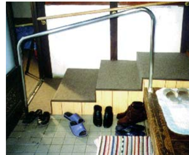
▲玄関の段差に階段と手すりを設置する
