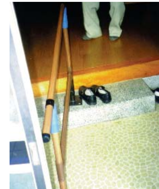
▲玄関の中央に床付手すりを設置
