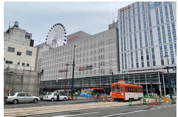
交通・交流拠点となる松山市駅前広場整備
