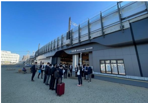
R6.9 高架切替え、新駅舎開業
