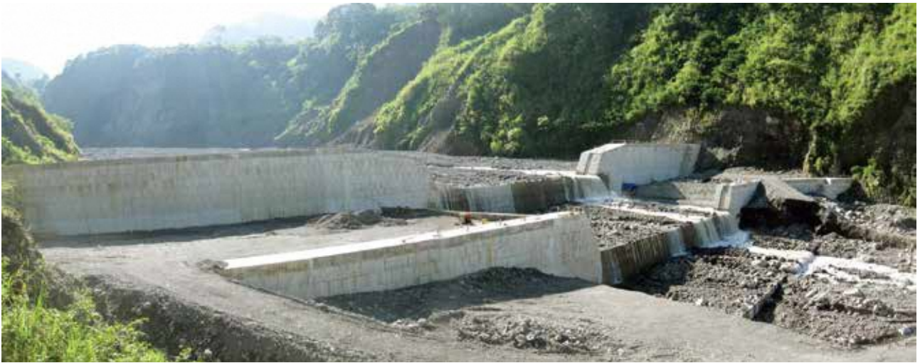
インドネシア：ジェネベラン川の砂防堰堤
