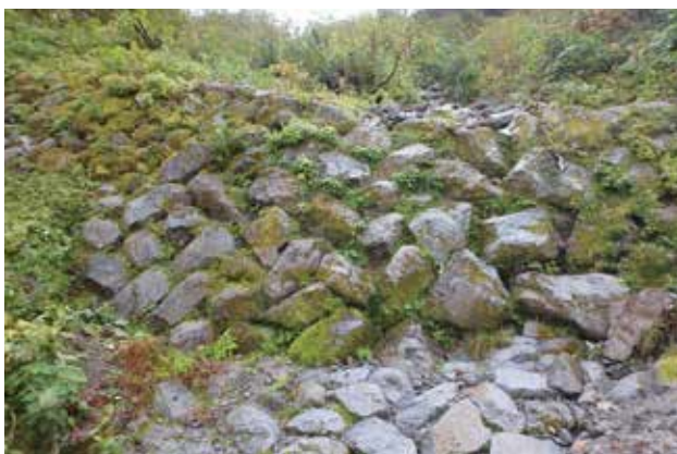
県営砂防施設（空石積溪間工）
