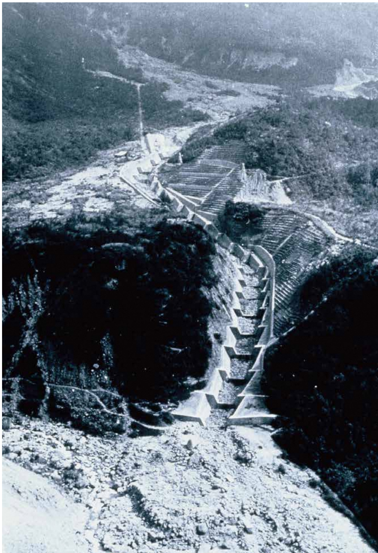
竣工時の泥谷堰堤
