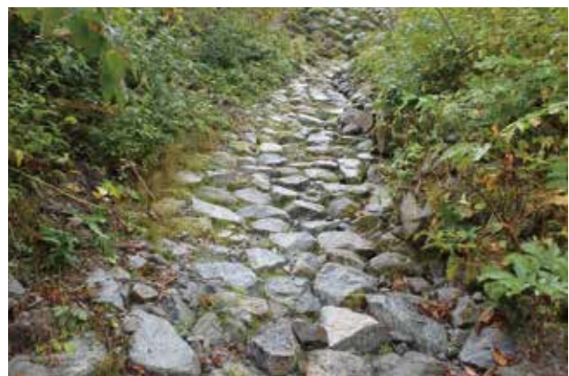
県営砂防施設（石貼水路工）
