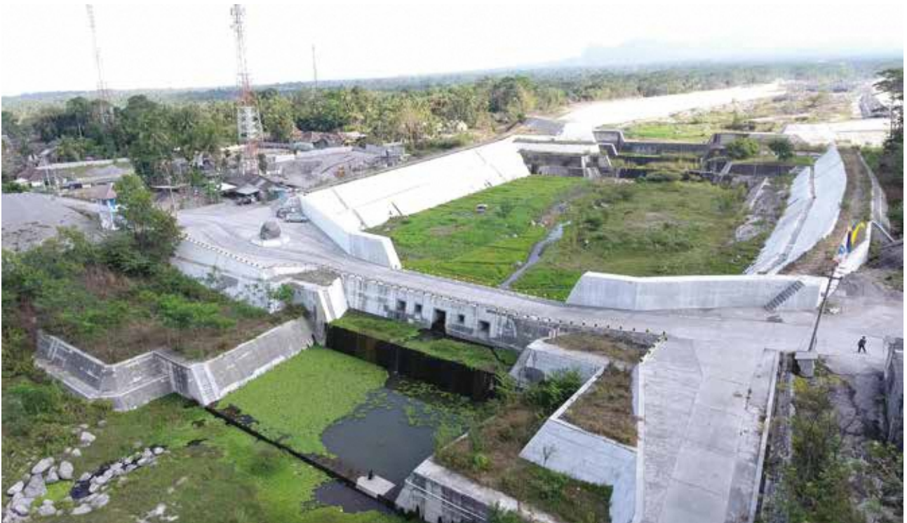
インドネシア：メラピ山 ゲンドール川の砂防堰堤と導流堤
