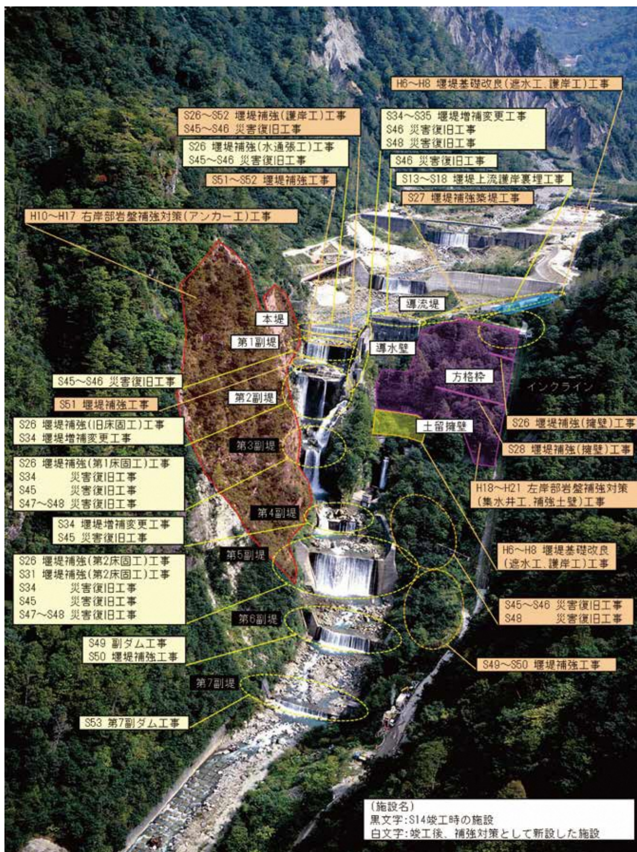
白岩堰堤の補修・補強対策の履歴
