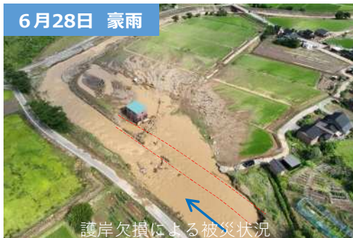
護岸欠損による被災状況
