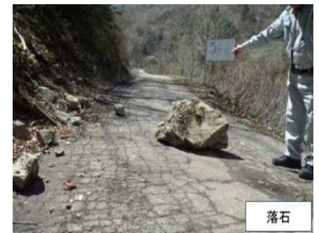
ダムへの危険なアクセス道路
