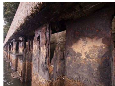
鋼矢板の腐食が著しく、穴が開いている。この段階まで進行すると鋼材の取替を行うなど抜本的な更新が必要となる。
