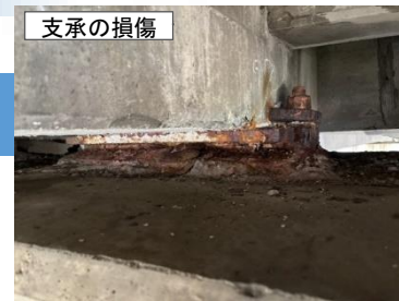
橋梁の老朽化対策 (県道八幡田稲荷線 稲荷町跨線橋の損傷状況)
