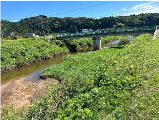
河道浚渫実施前(余川川)
