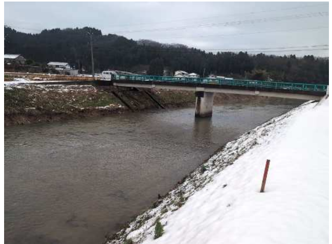
河道浚渫実施後(余川川)
