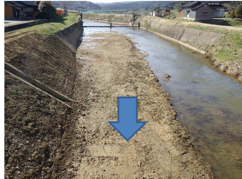
河道浚渫実施後(余川川)
