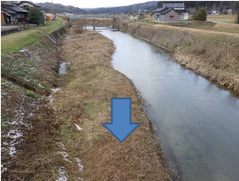
河道浚渫実施前(余川川)
