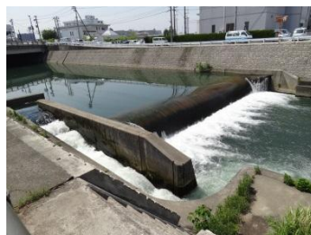
いちち川取水堰 (平成12年度設置)
