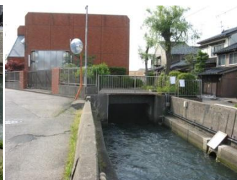
内川浄化揚水機場 (昭和56年度設置)
