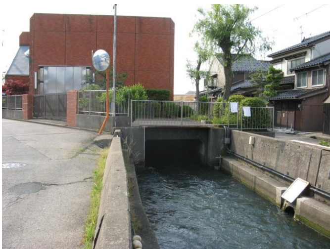
内川浄化揚水機場（射水市）
