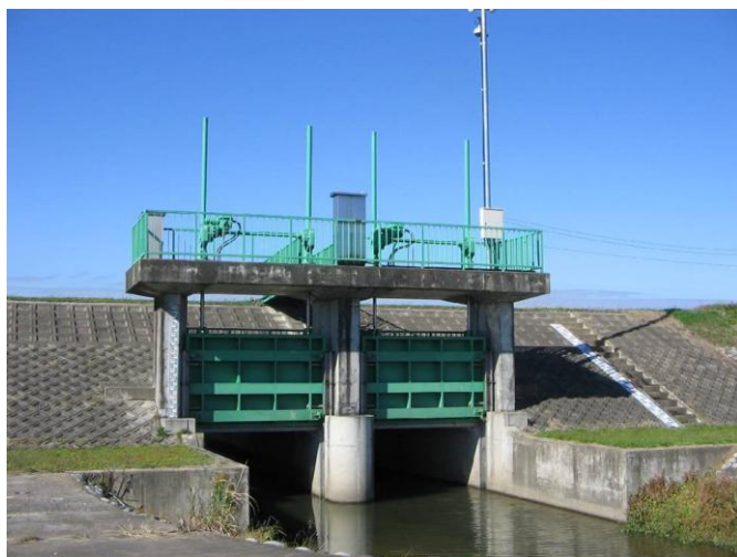
小矢部清水川樋門（小矢部市）
