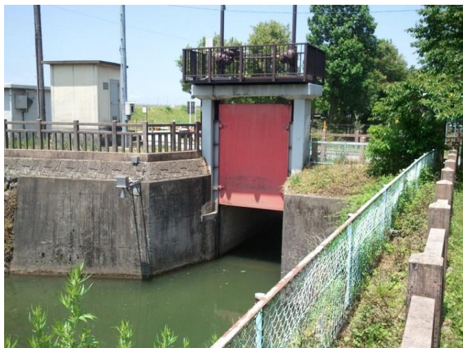
松川制水門（富山市）
