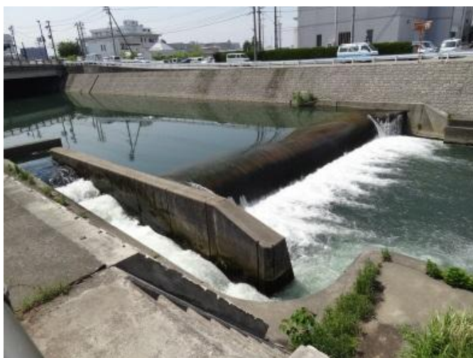
いたち川取水堰（富山市）
