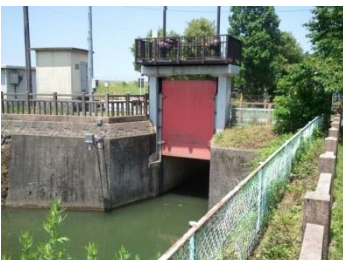
松川制水門 (昭和41年度設置)
