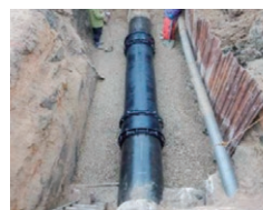
農業用水パイプラインの復旧▶
