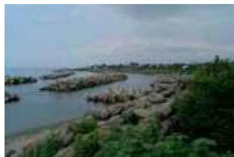
消波ブロックの覆われた人工的な海岸
