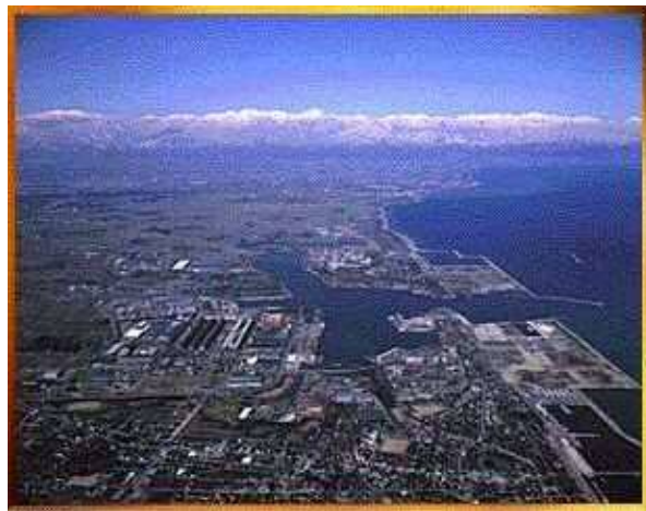
伏木富山港新湊地区(富山新港)
