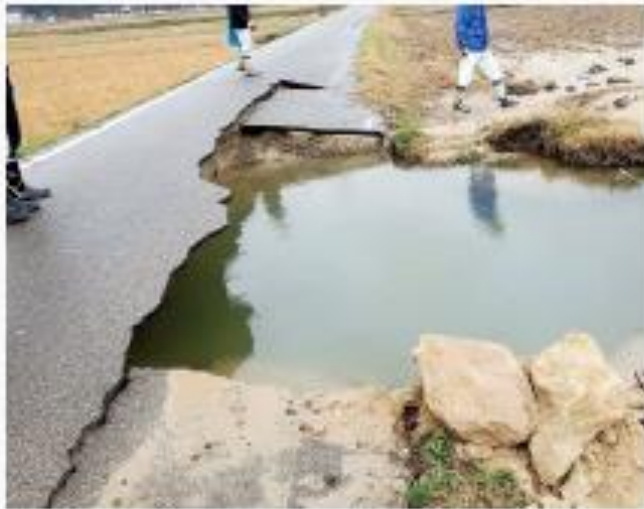
▲被災状況(農業用パイプラインの破損)
