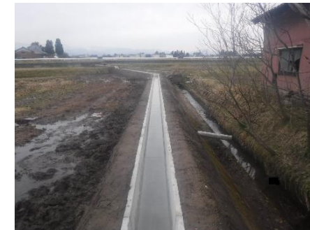
農業用水路の改修(改修後)
