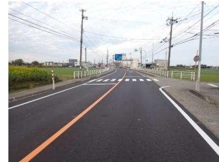
道路の舗装補修(補修後)
