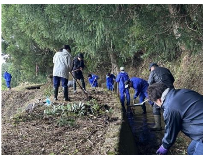
農村農業ボランティアによる 用水路の清掃 (とやま農業・農村サポーター)
