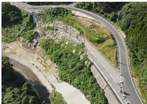
崩壊した道路斜面の復旧
