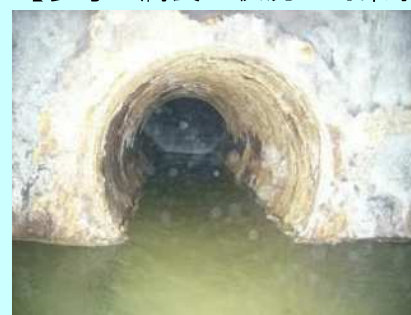
コンクリート表面が腐食
