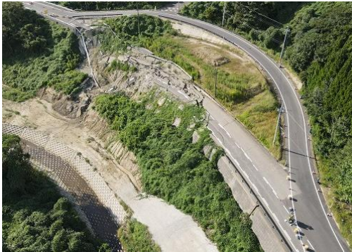
崩壊した道路斜面の復旧
