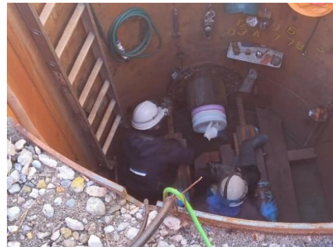
「地下水位低下工法」の実証実験
