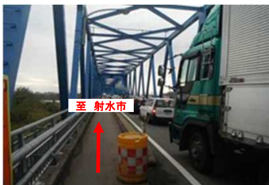
(国)415号 新庄川橋付近
