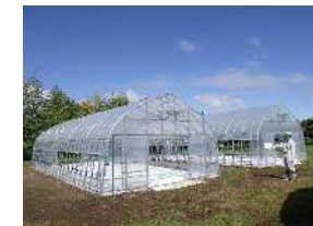
育成用ビニールハウスの造成
