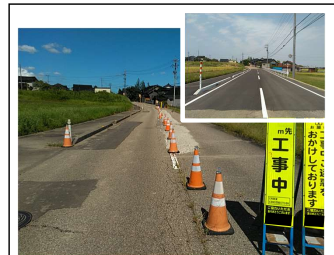
県道砂子谷埴生線 災害復旧工事 （小矢部市松尾）令和7年5月完成
