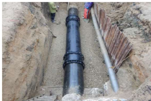
農業用水パイプラインの復旧
