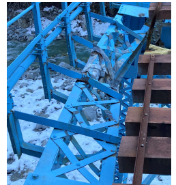
黒部峡谷鉄道 鐘釣橋 落石による被害
