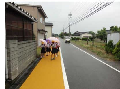
道路の交通安全対策（歩道整備）
