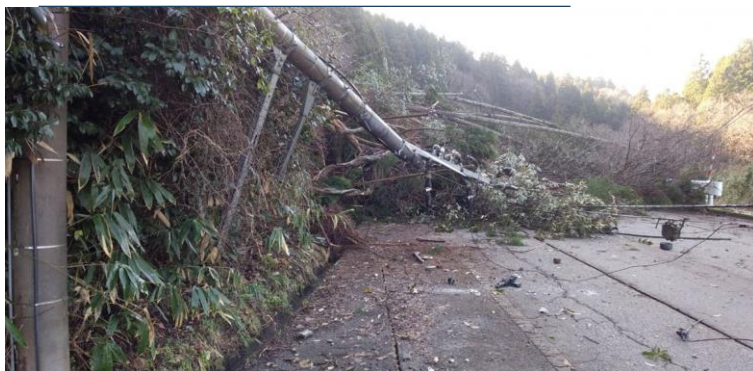
電線を巻き込んだ道路の啓開訓練 （土木事業者、電力事業者等の協同訓練）
