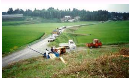
ため池への送水管の設置
