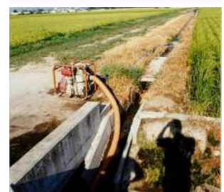
排水路へポンプ設置
