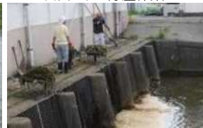
スクリーンの除塵作業
