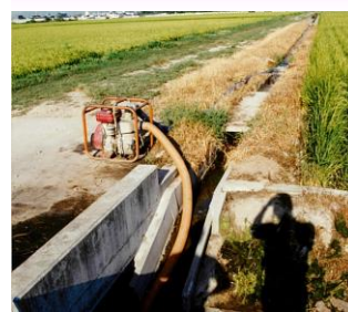
排水路へポンプ設置
