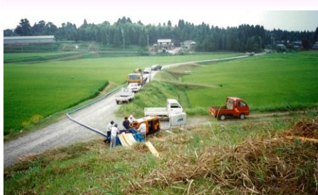
ため池への送水管の設置
